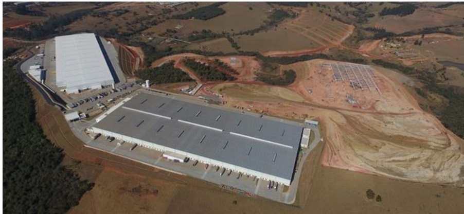
Complexo Extrema Business Park – Blocos I, II e III (terreno/em construção)
